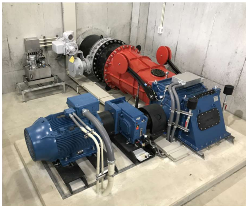
J L A ハイドロ社 (ベルギー) クロスフロー水車
